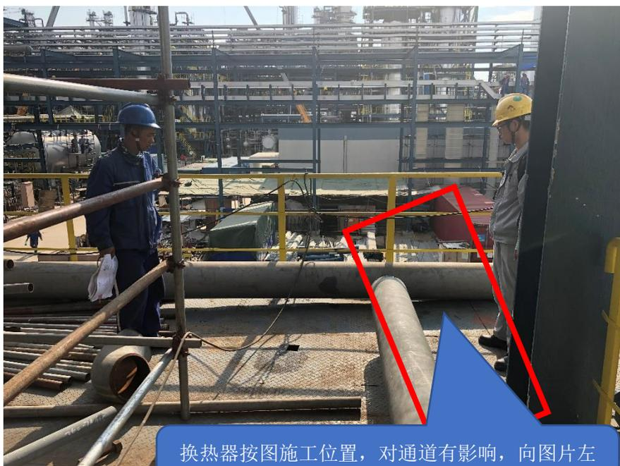
换热器按图施工位置，对通道有影响，向图片左边进行平移，可能会影响换热器抽芯检修
