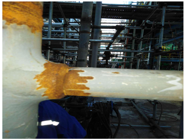
P209B 出入口跨线一端焊口未焊接 徐波
