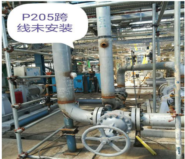
阀门未保护内部铁屑多。刘升升
