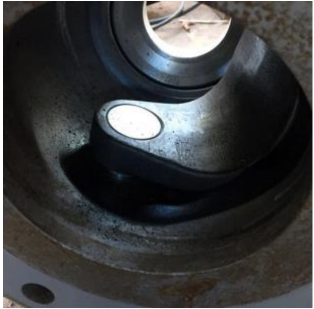
阀门未保护内部铁屑多。刘升升
