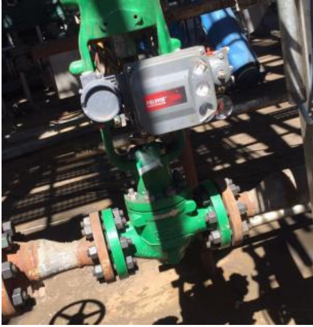
新鲜碱液线入装置流控阀方向装错。刘升升
