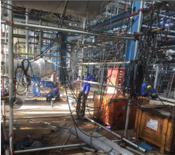
E216 打压完成后未接管线排放。刘升升
