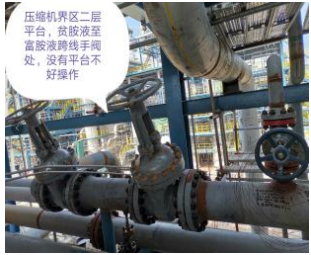
压缩机界区二层平台胺液循环线手阀需增加操作平台 方云英
