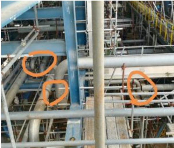
加裂低低压蒸汽去 M204 管线尚未完全连接 邓乔
