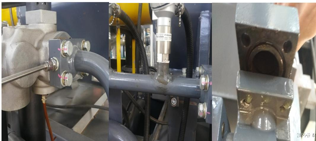
7) 因 SV002A/B 爆破片夹持器缺少爆破片压环，备件未到，安全装置不能投运，将爆破片更
