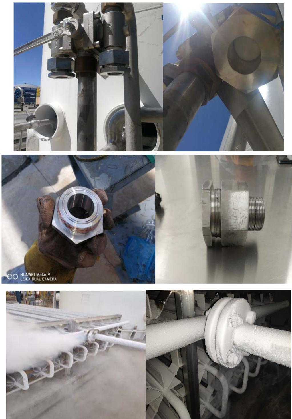
8) 5月29日,启动空压机K001B时,发现出口单向阀法兰漏气,紧固后仍漏,拆检发现石棉垫片硬化开裂,更换为缠绕垫。
