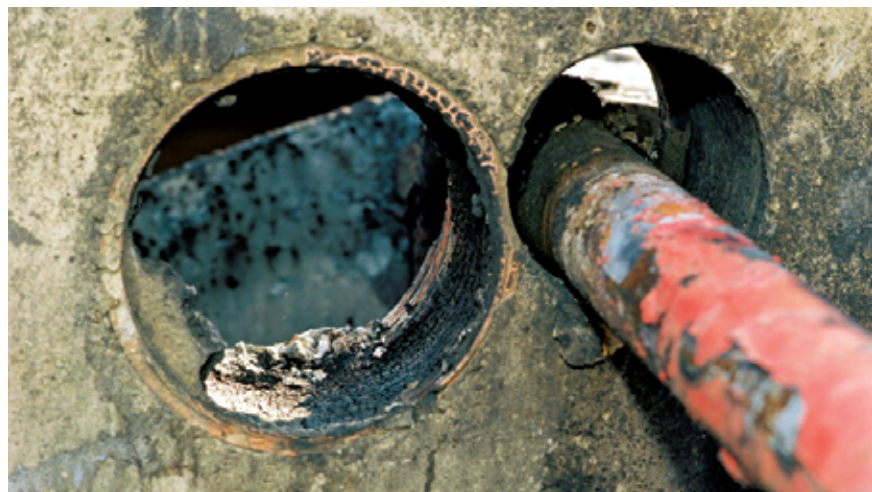
贯穿管道与防火堤之间的密封泄漏
