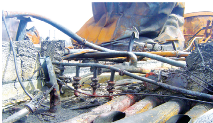
管道贯穿中灾难性的防火堤失效
