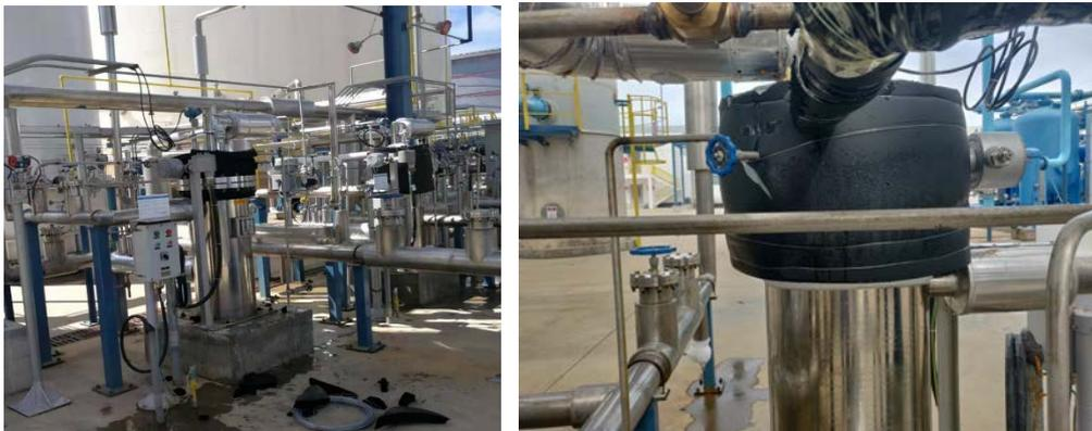
3) 10日, 低压液氮泵出口总管安全阀在0.7MPa时起跳, 对安全阀V00632调校发现安全阀0.8MPa起跳, 重新整定至0.88MPa。
