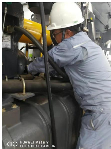
2) 7月9日, 中压液氮泵运行正常, 泵体与管线结冰跑冷, 对泵体及附属管线进行保冷。
