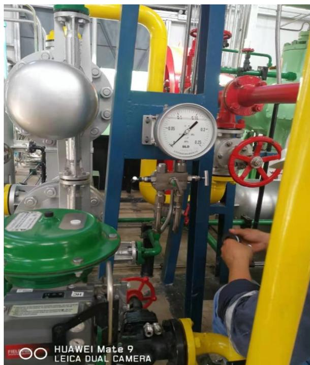
5) 7月10日,发现低压水浴式汽化器(WH001)液氮进口法兰漏,拆保冷,紧固泄漏。
