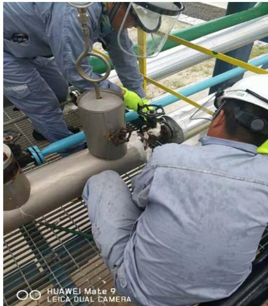
2) 7月10日，监测换热器厂家腐蚀率探头到货，仪表更换探头，显示仍不正常，仪表继续处理。
