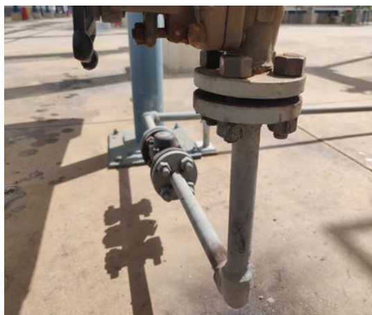
疏水器法兰消漏
