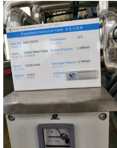
包机牌的正在安装名字牌
