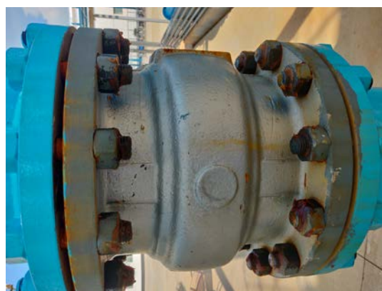
仪表风干燥器阀门多余润滑脂清理
