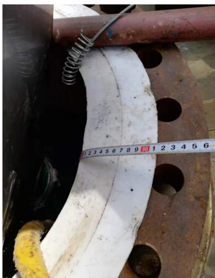
图 5 脱硫剂装填检尺
