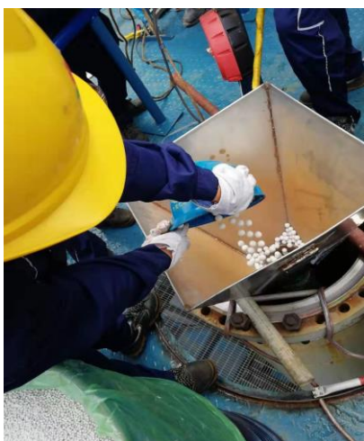
图 3 56-D105 装填瓷球
