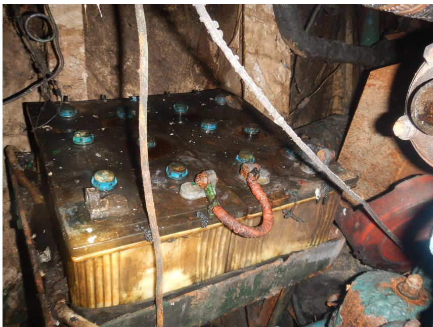
图 17 发电机启动电瓶
