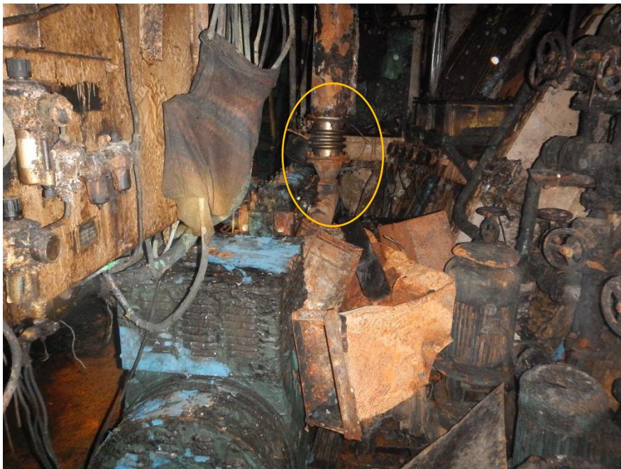
图 11 3 号发电机排烟管
