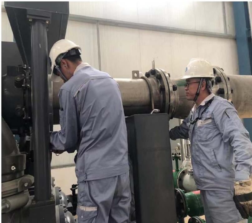
1) 开工过滤器滤网无破损，表面有干化黑色污垢及 2 片管道施工封口用透明胶带；
