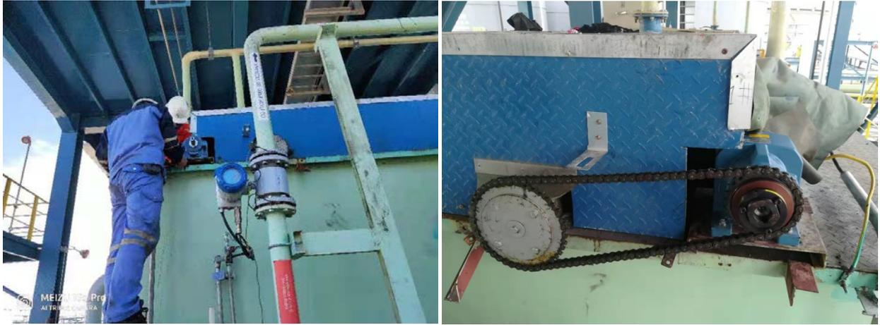
2) 含油/含盐均质罐排泥泵 P1003A/B, 考虑介质中含泥量高, 机封自冲洗易在格兰中结垢堵塞, 安排设备检修部将机封自冲洗改为生产水外冲洗, 可延长机封使用寿命。
