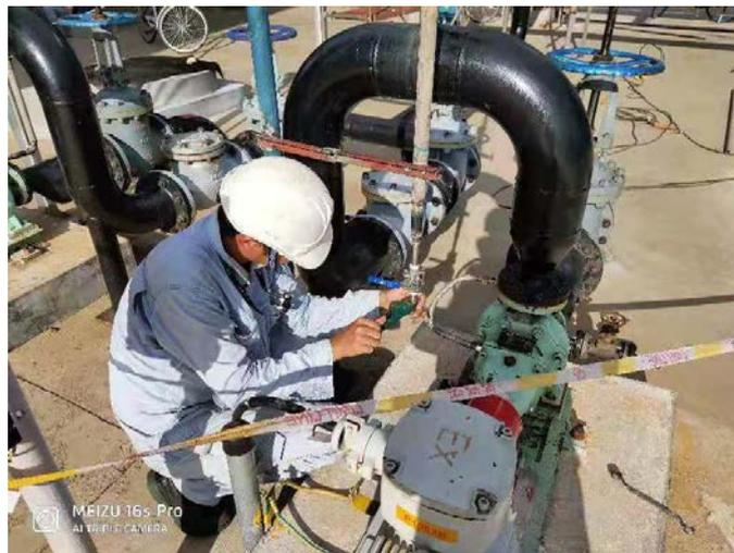
3) 本周参加污水提升泵站六两台污水提升泵的单机试车工作, 泵试运正常。
