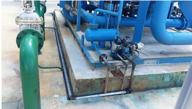
2) 18 日，班组发现膨胀机润滑油总管油压下降（由 900KPa 降至 860KPa），现场检查没有异常，切换润滑油过滤器，油压没有变化，与设备厂家技术人员联系，建议调高油压，观察运行，将油压调整至 950KPa，观察运行无波动。
