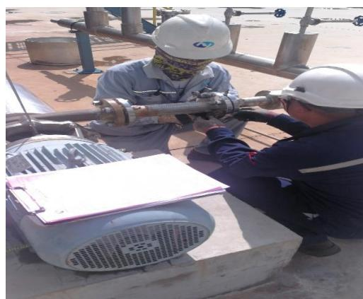
2) 11月13日，检查发现自吸泵电机底部有 4 处排气孔向联轴器侧漏水，联系设备维修部对排气孔封堵。
