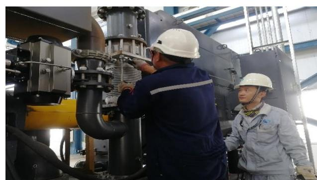
4) 15 日, 检查发现 SV002A 自增压器法兰漏, 联系维修人员紧固消漏。
