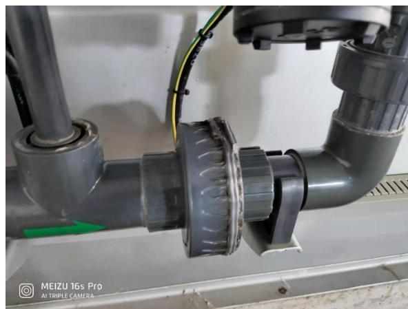
4) 11月28日巡检发现P2009B泵机封冲洗水管线断裂，联系检修部对其进行焊接。
