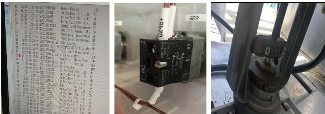
2) 11月29日，班组检查发现装置区制冷站溴化锂机组 5603-WCH002B 热水阀开度 PLC 与现场阀位不一致，PLC 全关，现场仍有 5% 的开度，联系电气人员调试电动阀，在更换线路板时，造成机组断电停机，启动备机，运行正常。更换线路板，调试阀门正常。
