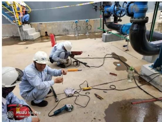
2) 12月3日，发现 P1004A 泵不上量，联系设备检修部对滤网进行清理。
