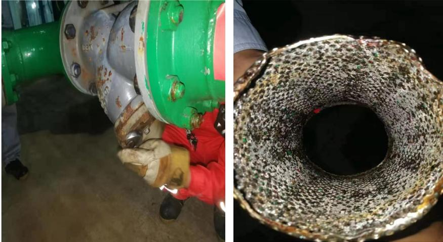
2) 12月5日，对停运的空压机 K001D 润滑油过滤器导压管接头更换消漏。
