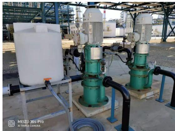
2) 12月11日清理湖水P306A/B泵入口过滤器，大多是青苔和淤泥。回装后运行正常。
