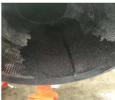
后 4 台泵入口过滤器先后出现堵塞，清洗时将细网拆除，骨架回装。
