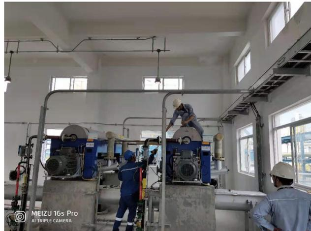
5) 12月21日, 巡检发现三楼涡凹气浮 PA1007B 链条脱落, 联系设备检修部对其进行复位。
