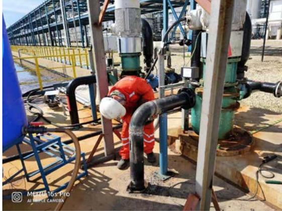
2) 12月19日，雨水监控P09B泵运行时出口管路振动大，怀疑泵入口堵塞垃圾杂物。安排检修人员拆卸泵出口止回阀，对泵进行反冲洗后泵运行正常。
