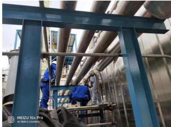
4) 12月18日, 巡检发现离心脱水机仪表线被老鼠咬坏, 联系设备检修部配合离心脱水机掀盖, 同时联系仪表修复仪表接线。
