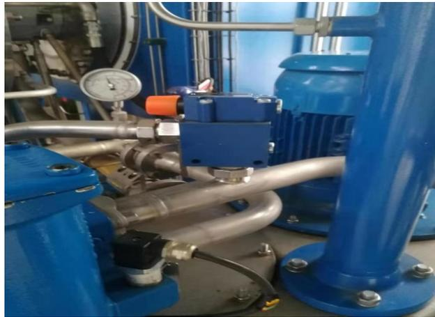
2) 2019 年 12 月 26 日，周检发现空压机油过滤器、导压管、油箱油雾过滤器等多处法兰、接头有渗漏现象，对各处漏点、法兰进行紧固处理，观察运行状况。
