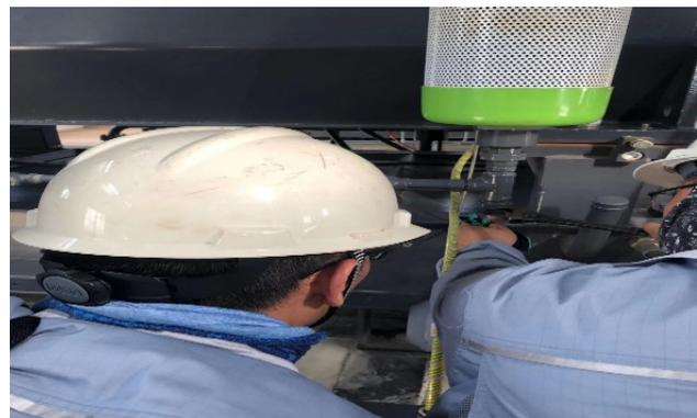
3) 2019 年 12 月 28 号，氮气增压机 K003A 过滤器压差表零点漂移，拆了重新校验零点，并在校验台上重新打压，指示正常。
