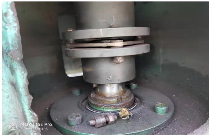
5) 2020年1月5日, 5152-P2010C 污泥回流泵不打量, 停运检修时发现叶轮被异物堵塞, 清理出一双搅碎的手套, 清理后运行正常。
