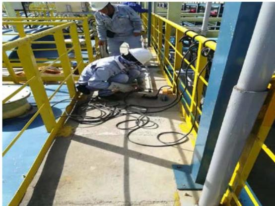
3) 2020年1月3日, 溶气气浮罐玻璃管液位计进行定期拆装清洗。
