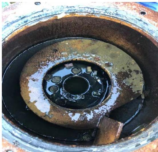
3) 2020年1月21日, 预处理框架含盐/含油溶气气浮塑料观察孔盖板变形, 更换厂家赔付的铝合金盖板。
