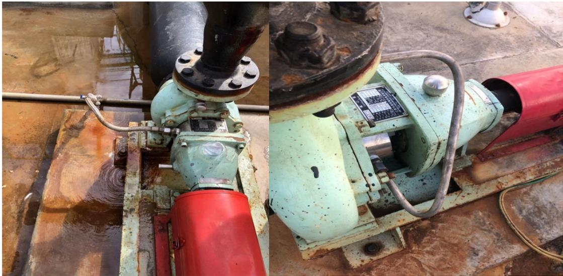
2) 2020年1月22日，5152-P1004B污水池提升泵不打量，拆检发现泵叶轮堵塞，清理出填料等杂物，清理后运行正常。
