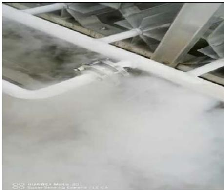
2) 此前中压液氮泵 NP003A 轴承声音有异响，2月7日按计划检修：拆检后发现轴承保持架断裂，更换轴承和O型圈，测量各部间隙，脱脂后回装完毕，排气管线增加配对法兰（方便拆装）焊接完成后脱脂，露点吹除合格，进行冷泵查漏，
