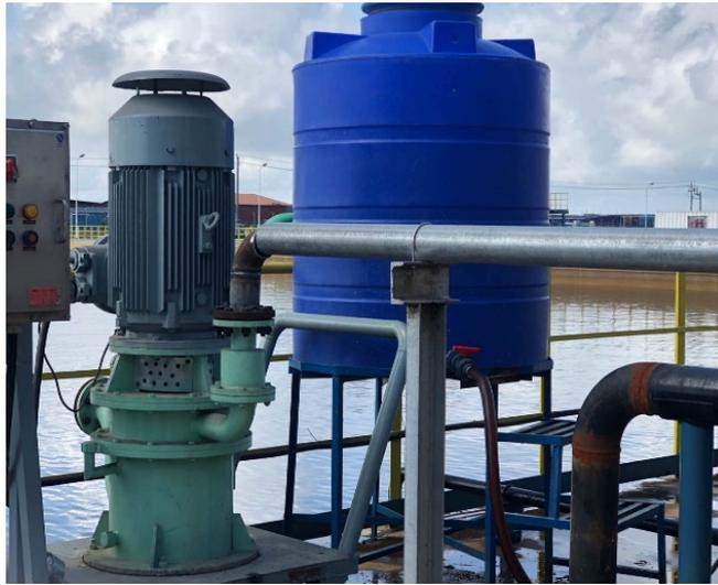
2) 2020年02月6日，雨水监控池 P08 自吸泵泵腔灌泵管线增加球阀，方便后续灌泵。
