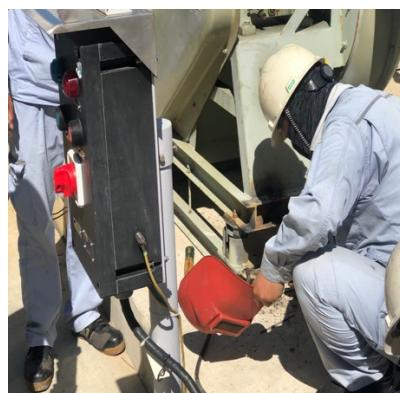
3) 2020 年 2 月 26 日, 巡检发现浓硫酸泵入口 Y 型过滤器堵头漏, 拆检发现垫片变形严重, 更换垫片后运行正常。
