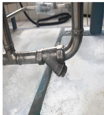
4) 2020 年 2 月 27 日, 5152-P1004A/B 出口设计无排气导淋, 启泵时排气污水污染管道表面。为此, 将出口压力表引压管增加三通, 加设放空管。
