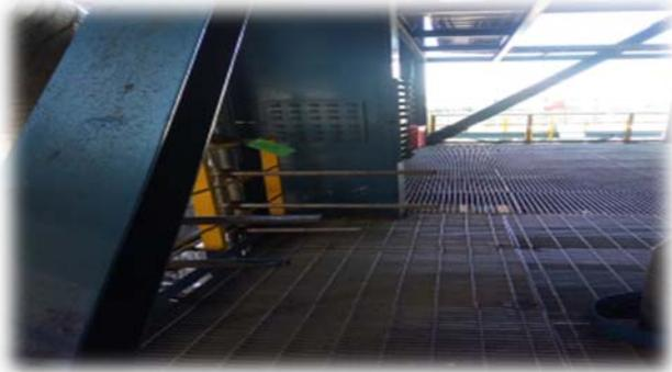
(2) 2月11日焦化 R-101 反应器框架 14 层检修现场杂物凌乱，地面油污沾染到走梯上，存在安全隐患。
