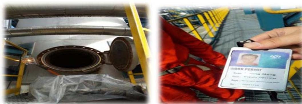
（5）2 月 17 日炼厂取水泵 VP-003A 检修，现场气焊气瓶未落实防倾倒措施。违反 GB/T34525-2017《气瓶搬运、装卸、储存、和使用安全规定》7.1.4 条“应将气瓶装入集装格或集装蓝中，并妥善加以固定”的规定。
