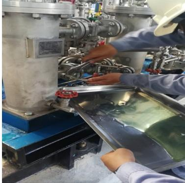
4) 2020年3月17日, K001C 空压机定期切换停运后, 对油系统法兰漏点进行消漏。
