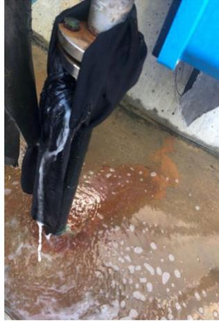
4) 2020年3月16日, 巡检发现 5152-P2002B 机封漏水, 拆检后发现机封损坏, 叶轮, 轴承损坏, 更换机封, 叶轮, 轴承, 运行正常。
