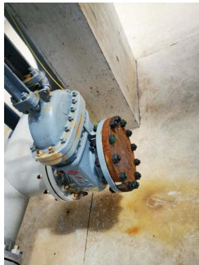
2) 2020 年 3 月 26 日, 湖水 5111-P301D 石英砂过滤器进水管线处法兰漏水, 联系设备检修部紧固法兰消漏。
