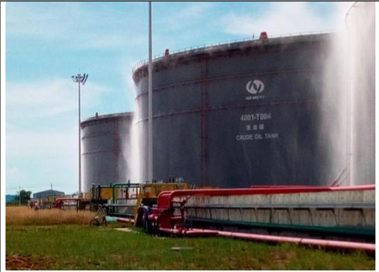
港储部成功投用 2#6#（相邻储罐）喷淋
