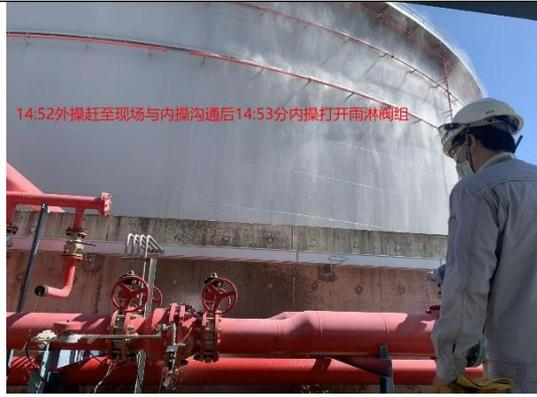
港储部启动 3#罐喷淋（保护相邻储罐）
