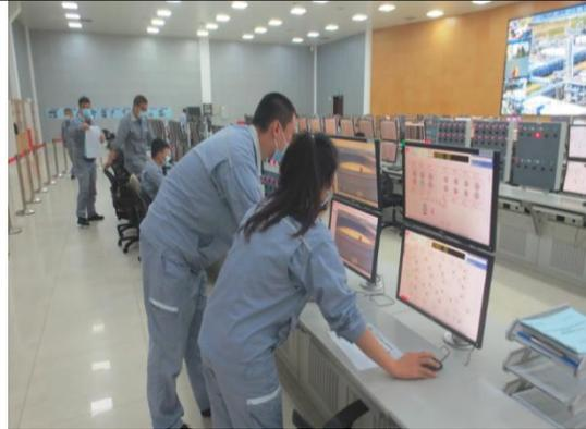
港储部内操远程启动泡沫站泡沫泵
